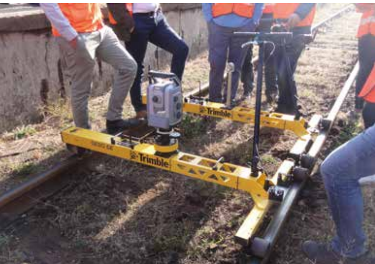
FOT. ARCH. CENTRUM DIAGNOSTYKI PKP PLK S.A.
