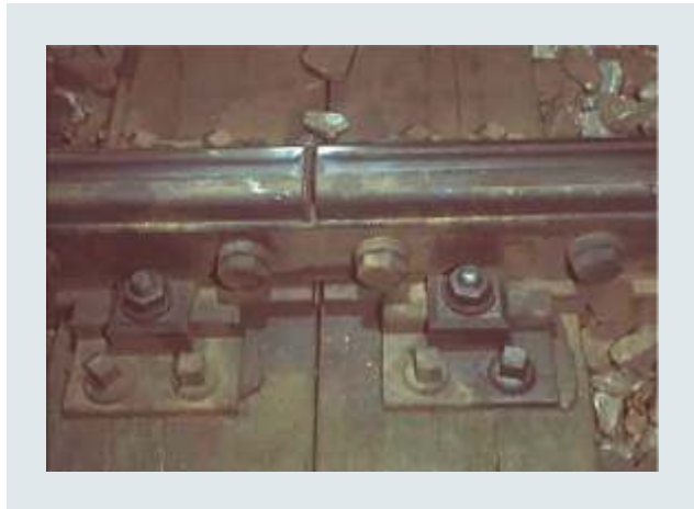
Pokładowy system inspekcji wizualnej zapisuje obrazy torów i rozjazdów.
